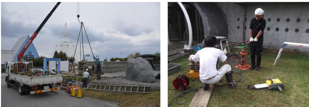
図1 ボーリング掘削作業の様子
