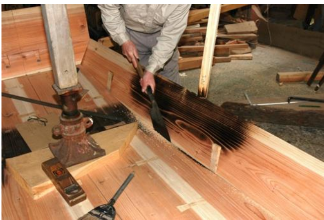
アイバスリ。材の隙間をノコギリで摺り合わせることで、隙間をなくし、水密性を高める。黒く焦げているのは、曲がった状態で木にクセをつけるヤキダメの痕跡。
