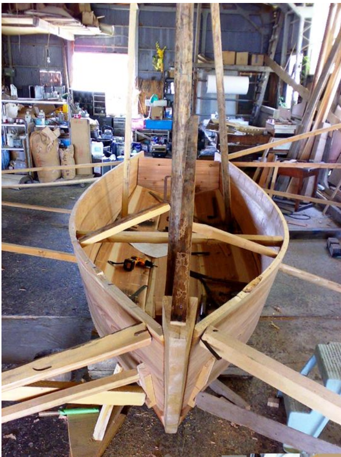
番匠造船で建造中のテンマ。船体を曲げ付けているのが角材のツカセ。
