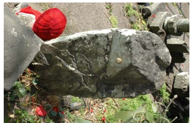
写真12 同碇石の背面状況
